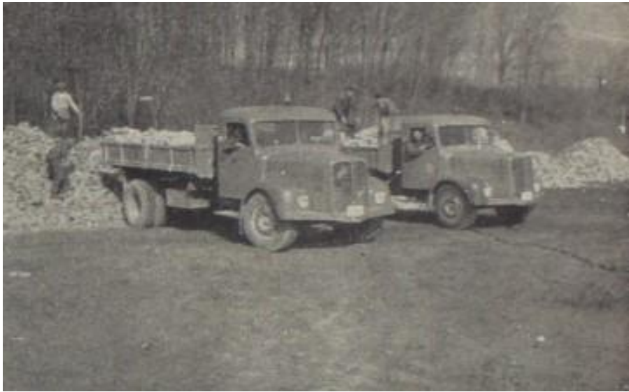
Слика 20. Транспорт материјала на градилишту
